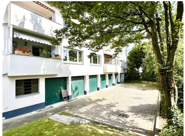
Rückwärtige Ansicht und PKW-Garagen
